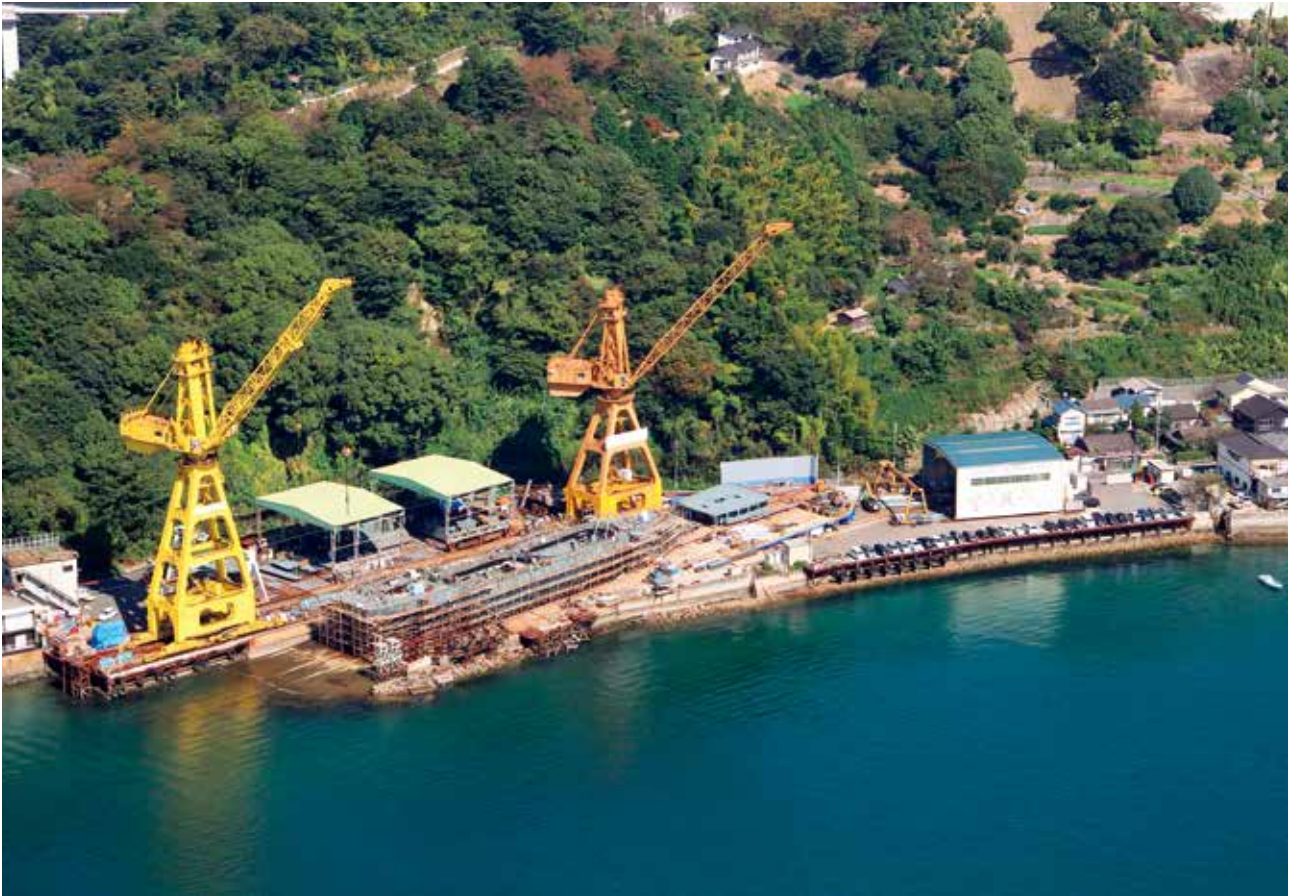
第二工場全景 Full View of Second Factory 船台 115.0m × 21.0m (G/T9,999)
